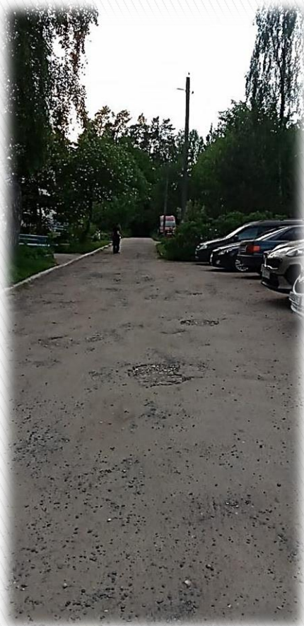
До проведения работ
