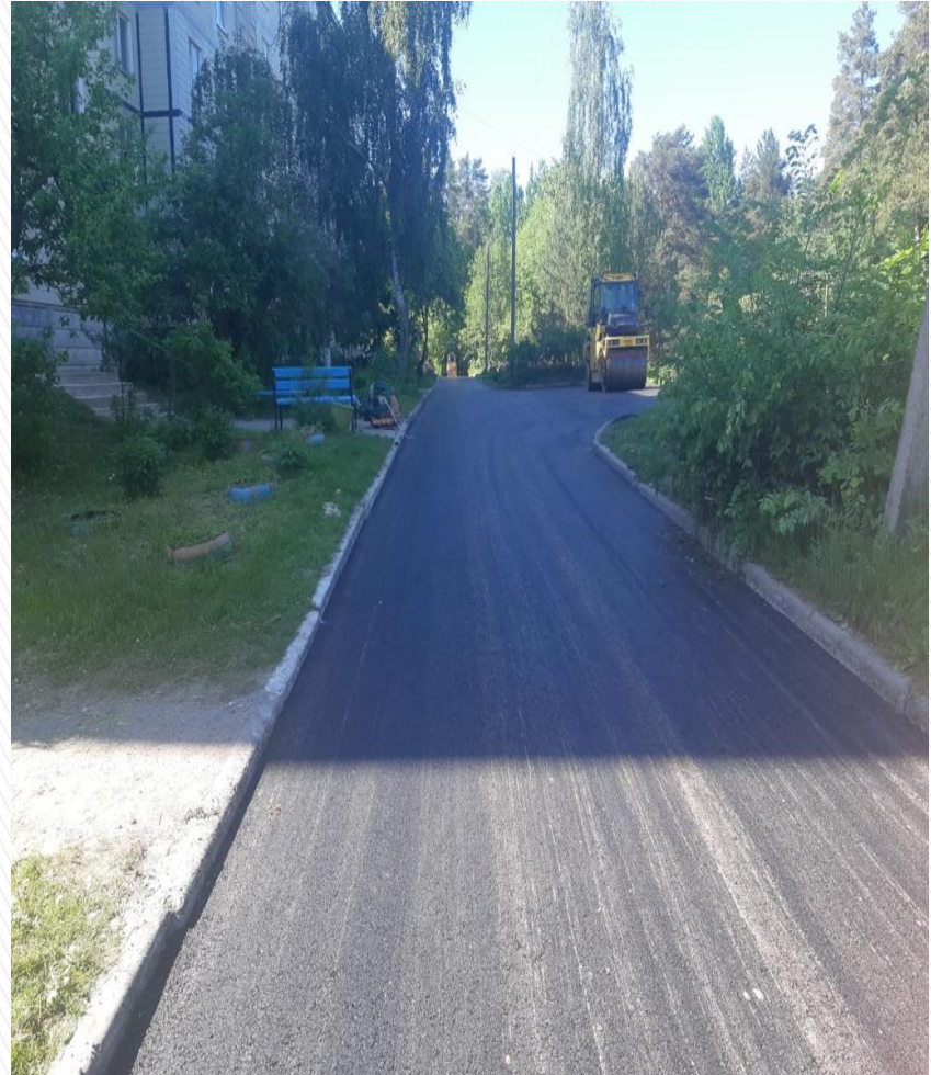
После проведения работ
